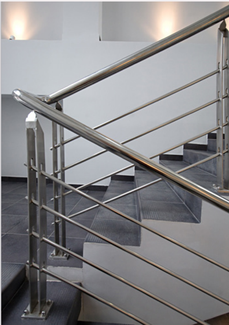
объект: Энергостройсервис материал стоек: нержавеющая сталь выполнено по дизайн-проекту заполнение: ригель \Phi 16 мм, нержавеющая сталь
