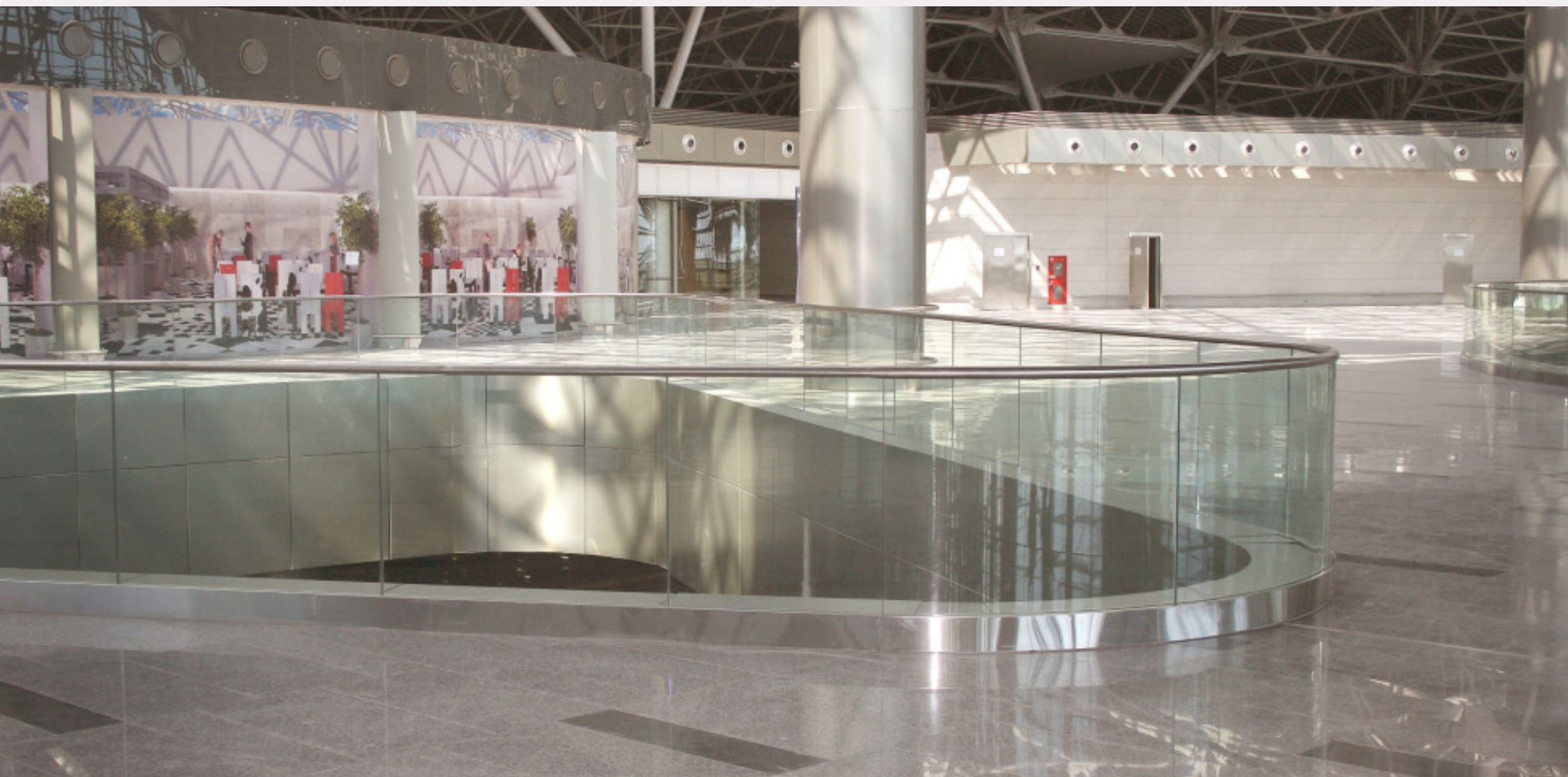
объект: аэровокзальный комплекс Внуково цельностеклянное ограждение по радиусу атриума
