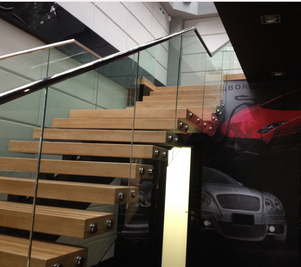
объект: салон AMG материал поручня: сталь открытое крепление стекла триплекс 8+8 закаленный
