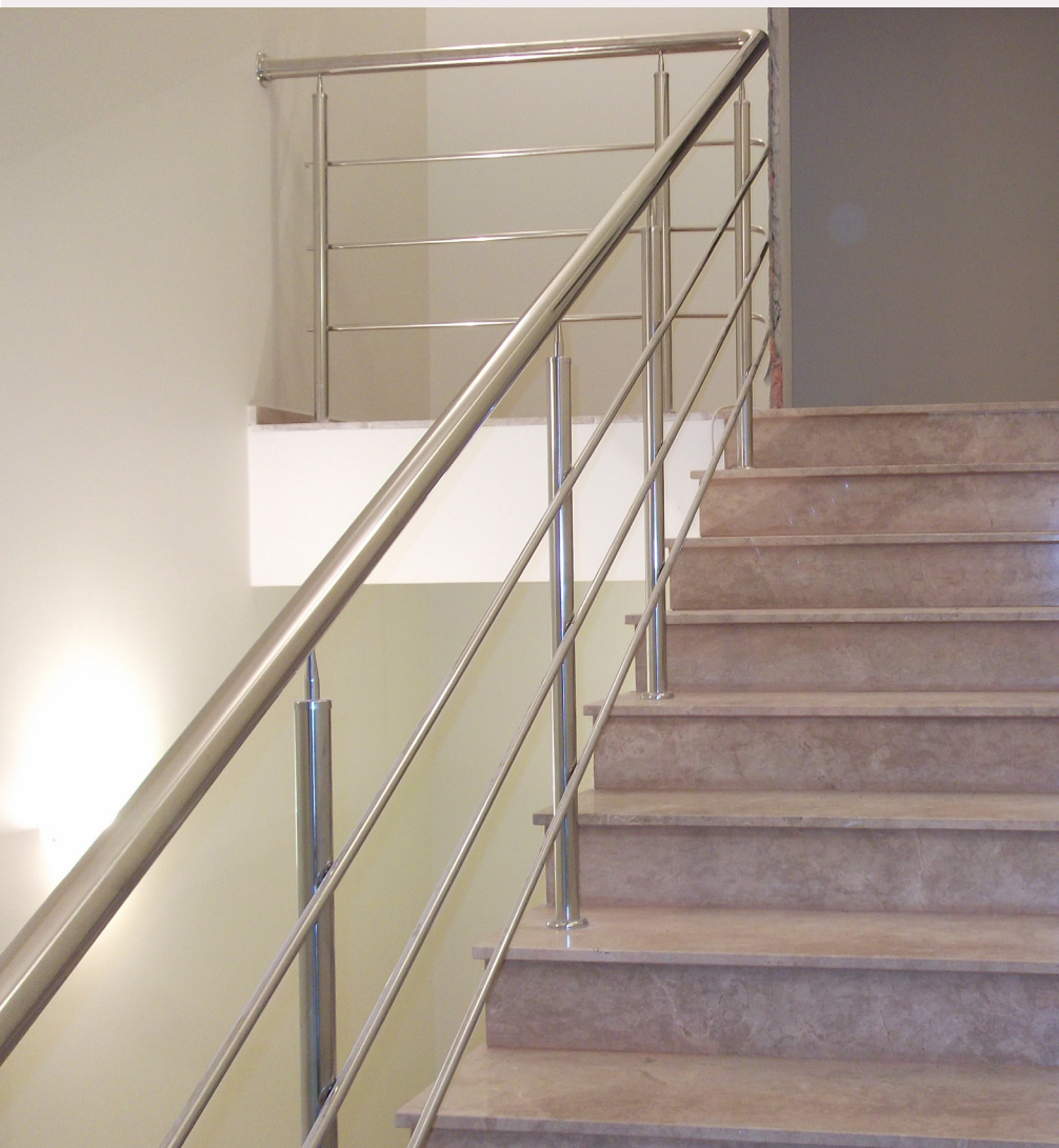
объект: ЖК Трилогия материал: нержавеющая сталь поручень Ф 51 мм стойки Ф 38 мм заполнение: ригель 16 мм, три ряда крепление: сверху марша
